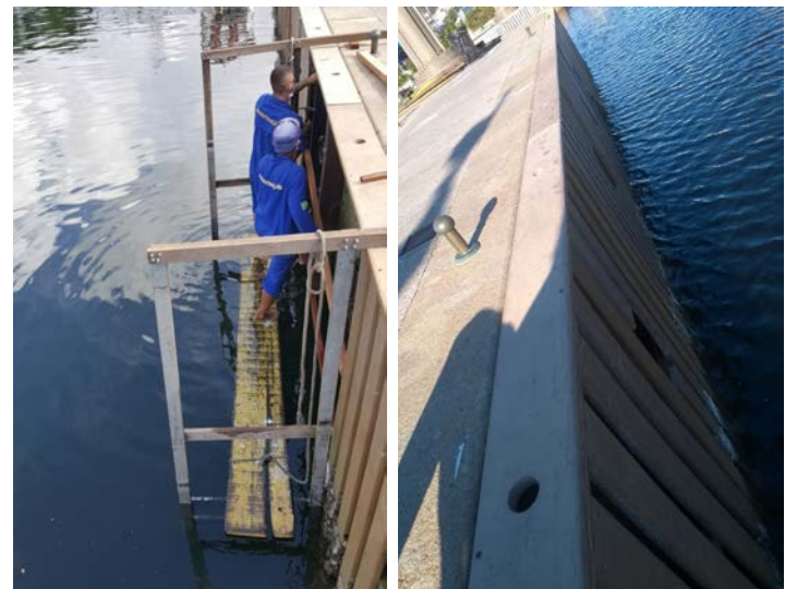
Conserto do cais (madeiras danificadas devido às ressacas)
