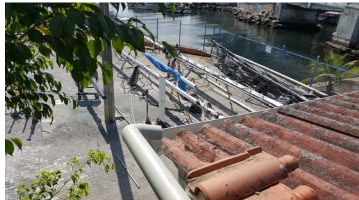
Término da instalação dos reservatórios de águas pluviais no hangar 1
