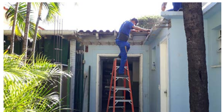
Reforma geral das câmaras frigoríficas da cozinha e da laje do Restaurante Social
