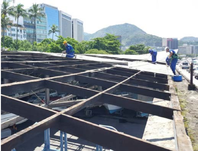
Continuidade da reforma do telhado do Hangar 5
