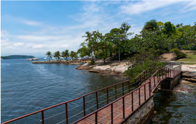
Ponte com manutenção e pintura recentes
